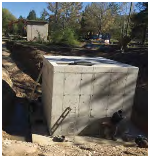
Travaux de mise en place des équipements de régulation aux captages de Bégudes
