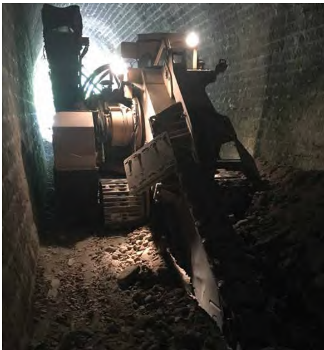
Travaux STEP Céreste
