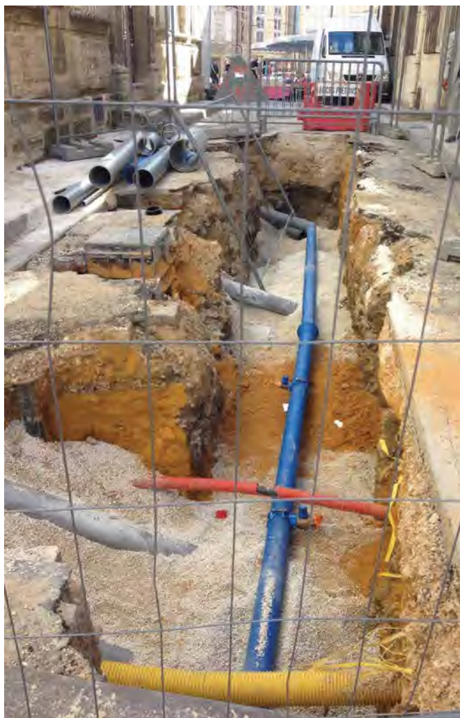
Renouvellement du réseau à Apt – Rue de l'Amphithéâtre
