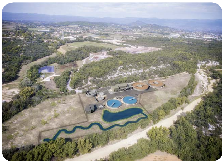
Située à proximité de l'actuelle station d'épuration implantée à la confluence entre l'Urbane et le Calavon au lieu-dit le Chêne. Mise en service fin 2020.
